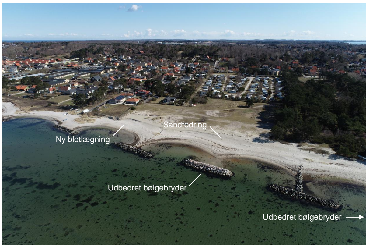
Figur 1. Dronefoto fra marts 2022 med markering af ny blotlægning af ledningen samt udbedringer og sandfodring udført i januar 2021.
